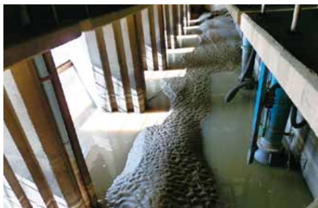
写真2：Tienfonteinポンプ場(南アフリカ) 土砂の堆積によりポンプが稼働できずダムへの導水ができない
