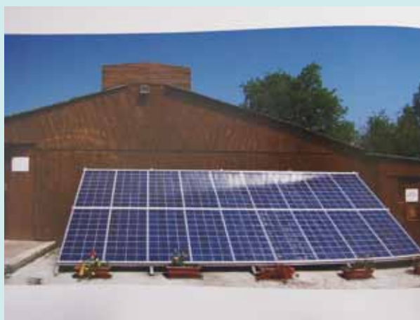
写真 2: ソーラーシステムを使用した畜舎
