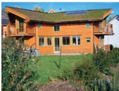
写真1：戸建住宅の傾斜屋根の一部分に置かれたソーラーパネル。小屋裏の空間を暑くせず、冬は保温性を高める。
