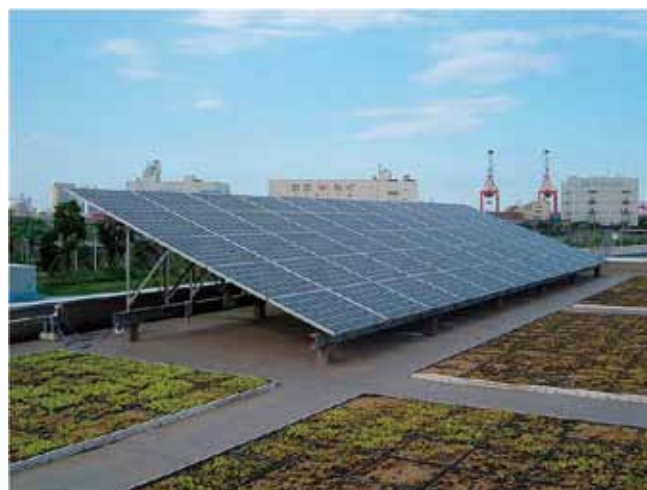
写真2：事務所ビル陸屋根の一部に設置されたソーラーパネル。芝生が生育しないのはいかという心配から、パネルの下は緑化されていない。その分、発電効率は低下する。
