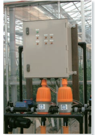
制御BOXと液肥混入器
