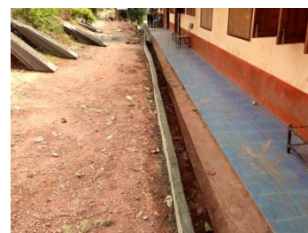
建設に取り組んだ水路
