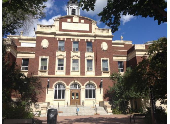
Register Building (大学管理オフィス)
