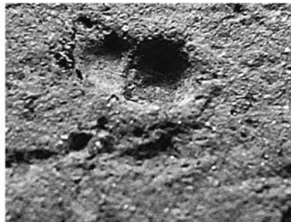
写真 37：底部外面に圧痕
