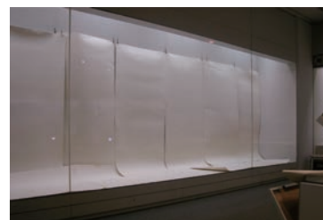
「エアチューンシート」による汚染物質の吸着処理
