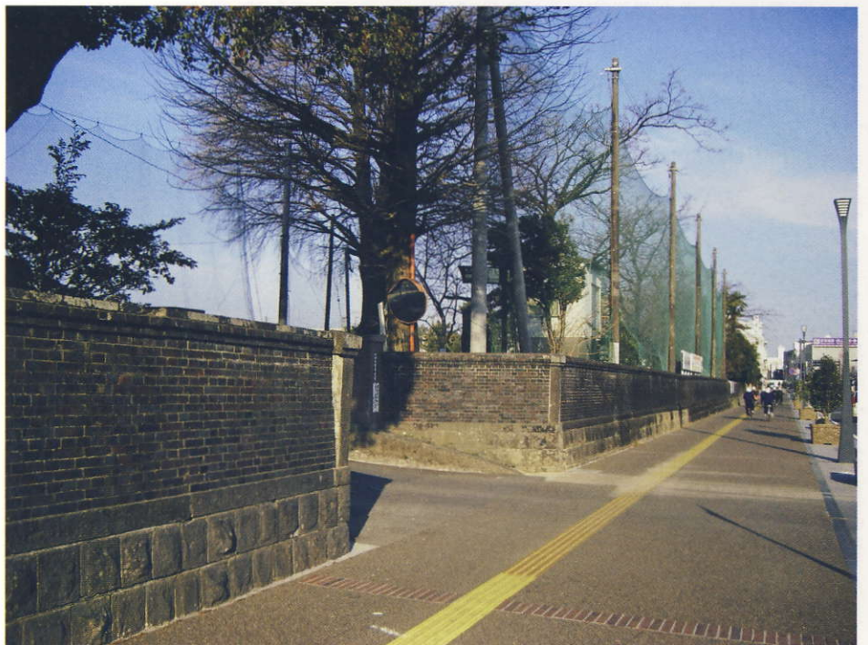
日平鉦山の鉦滓を混ぜた「からみ煉瓦」の堀(亮天社・延岡高等女学校址の岡富中学校)
