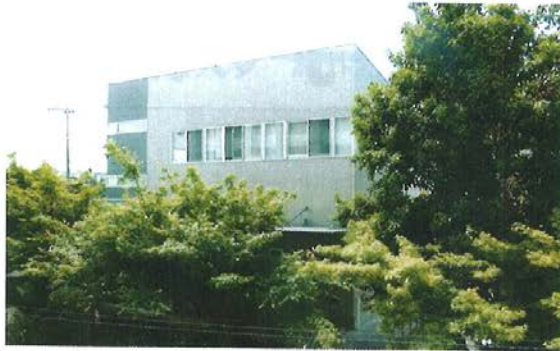
写真1 明治大学植物工場 基盤技術研究センター外観
