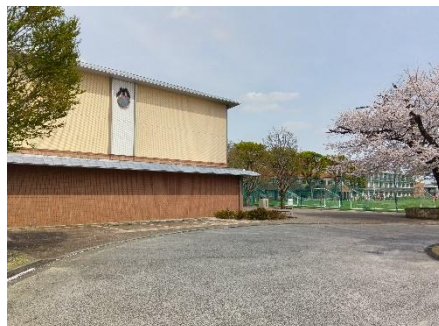
外壁改修工 を行った講堂棟
