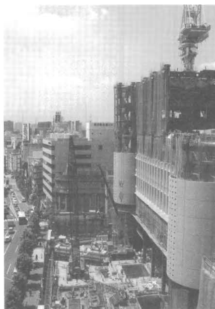
リバティタワー建設のようす（1997年）
