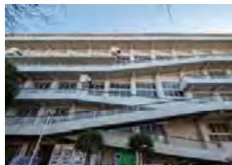
新キャンパス棟「和泉ラーニングスクエア」の竣工に伴い、2022年度に取り壊しが決定している和泉第二校舎（堀口捨己設計 1960年竣工）について記録保存を行いました。同校舎は1960年代の大学生の急増に対応するため大教室8室で構成された建物で、学生の移動をスムーズにするためのスロープなど随所に工夫が見られます。当時の日本における高等教育を象徴する建物として、DOCOMOMOJAPANの日本におけるモダン・ムーブメント建築物に登録されました。その歴史的な意義に鑑み、センターでは建物の点群データ測定、テクスチャー写真・建築写真撮影、ドローン空撮、堀口捨己資料アーカイブズのご高配を得て図面の一部デジタル化などの記録保存事業を実施しました。センターでは今後これらの記録を活用していく予定です。「さよなら和泉第二校舎」特設サイトは右QRコードからアクセスください。
