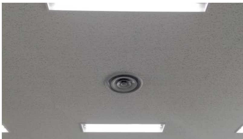
図 24 排気口のある天井の写真
