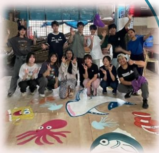
海上スラム： 教会の床の補修が完成
