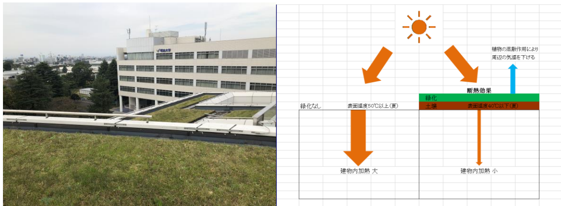
図書館の屋上緑化
