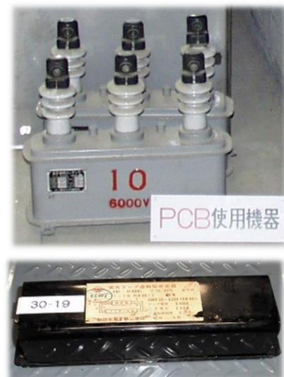
PCBが使用された電気機器類
