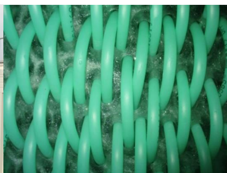
蓄熱槽内部（氷蓄熱後の状態）
