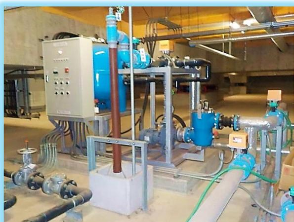
④ 雨水ろ過処理水(雑用水)を利用した実験用冷却システムのしくみ (第二校舎 A 館)
