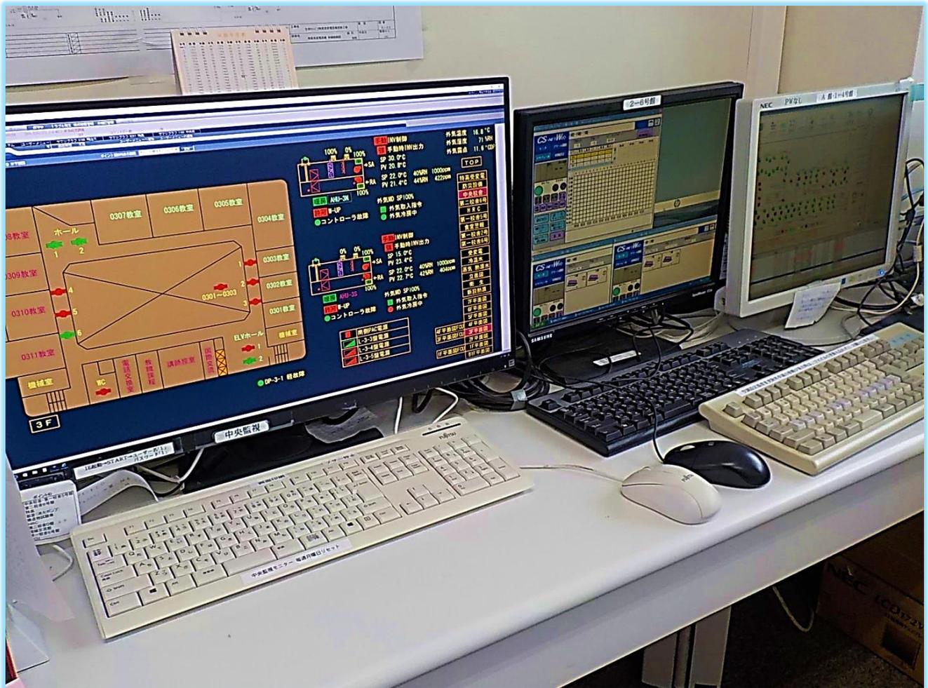
第二校舎 2 号館 1 階には、生田キャンパス全体の室温調整・電力管理・熱源調整・照明調整等を行う「中央監視室」があります。「中央監視室」は、生田キャンパス内部の様々な変化に対応するため、24 時間 365 日体制で業務を行っています。
