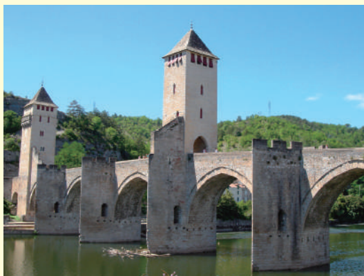
フランス／カオール ヴァラントレ橋
