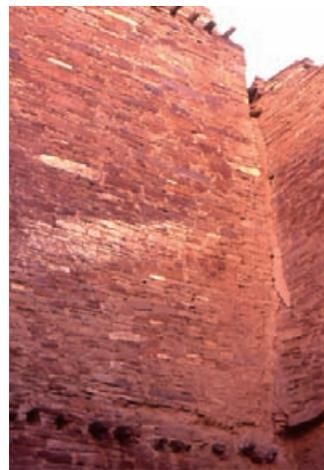
2)プエブロ・ボニト遺跡内、2階と3階の床を支持する木製梁が壁面から多数突出しているのがわかる。つまりこの建物は最低でも3階建て
