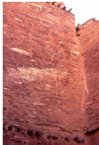
2)プエブロ・ボニト遺跡内、2階と3階の床を支持する木製梁が壁面から多数突出しているのがわかる。つまりこの建物は最低でも3階建て
