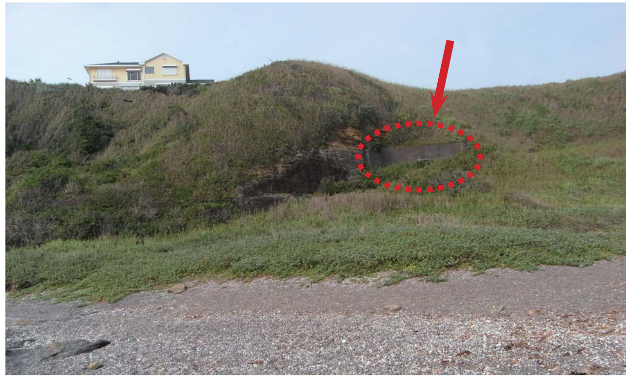
神奈川県横須賀市・黒崎洞窟砲台跡 海より上陸しようとする米軍を狙撃するため、水際に構築された。黒崎は回天基地が設置された荒崎南側に位置する。
