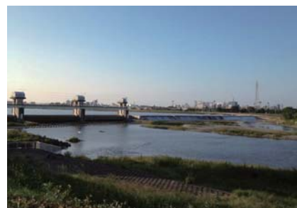
現在の多摩川の川崎市多摩区宿河原付近の堰。多摩川では偽札の灰を流しただけでなく、爆弾の爆破処理も行った。(資料館撮影)
