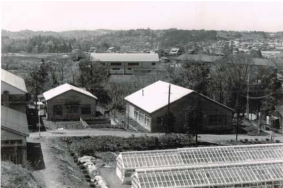
第一校舎1号館から現資料館方向の眺め 地図上位置⑨
