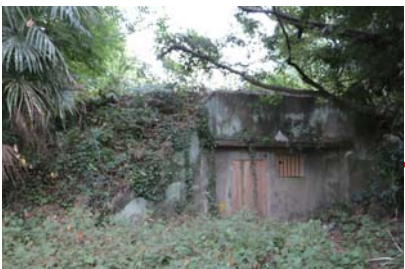
⑩旧倉庫跡
