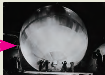
気密度検査（満球テスト） 空気を入れ、気体漏れがないか最終確認を 行う。
