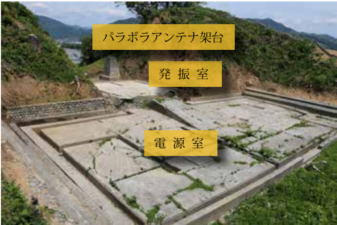
第二海軍技術廠牛尾実験場の電源室・発振室・パラボラアンテナ架台跡地（2014 年 5 月当館撮影、島田市教育委員会、島田宿・金谷宿史跡保存会調査協力）
