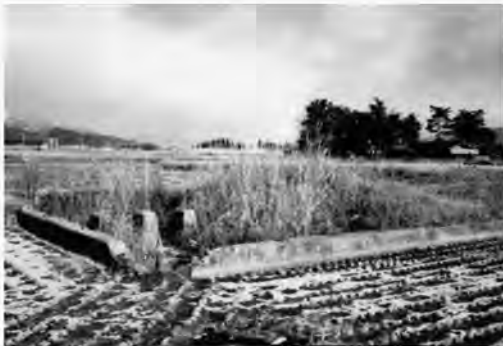
松川村に建設されていたパラボラアンテナ (電波兵器)の礎石
