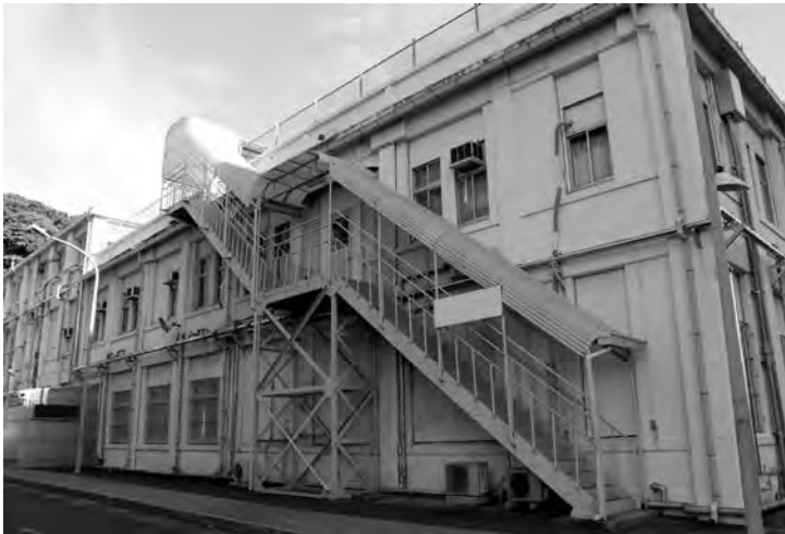
第 6 図 GPSO が使用していた建物 2015 年当館撮影。
