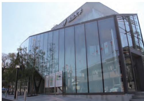
センター外観 Appearance of the Center
