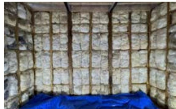
写真 13 廃布団による断熱施工後
