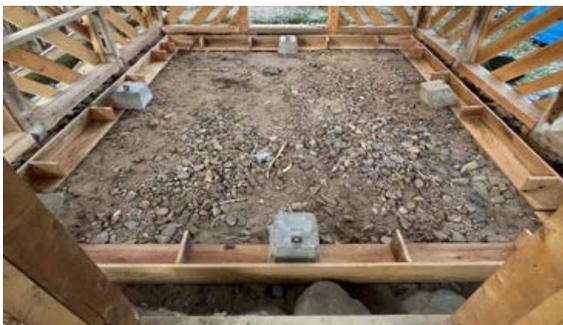
写真6 三和土による気密施工前
