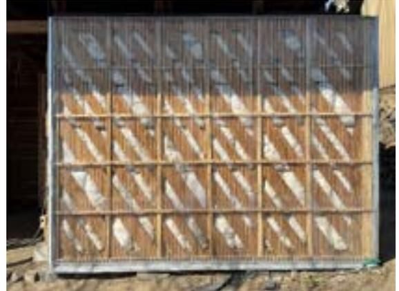
写真 19 ポリカーボネート外装施工後
