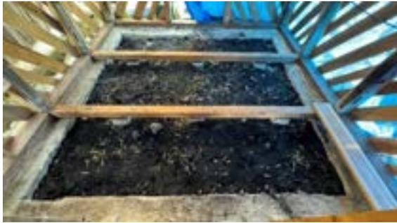
写真 8 粃殻燻炭による床下断熱施工前
