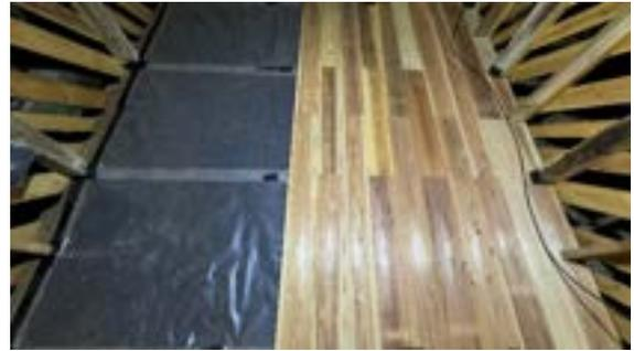
写真 9 粃殻燻炭による断熱施工後
