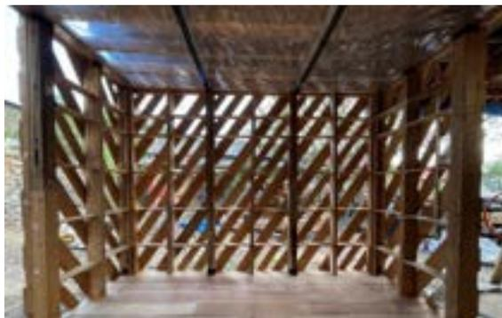
写真 12 廃布団による断熱施工前
