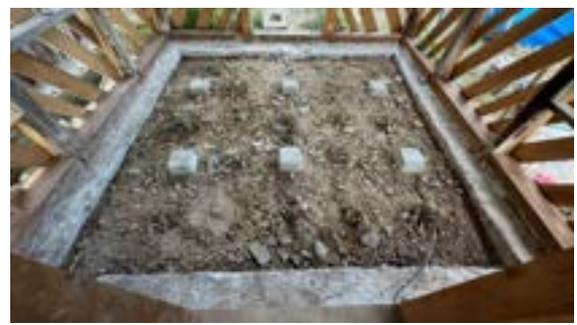
写真7 三和土による気密施工後
