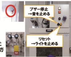
ガスの交換時に、ライン内のガスが漏れると確実に鳴動するので、必ずガスの交換手順通りに行なう事。
