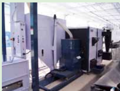
間伐材を有効活用した温室の暖房用のペレットボイラー
