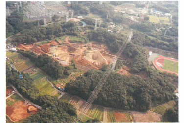
図3：黒川農場建設時の里山保全(戸田建設撮影)
