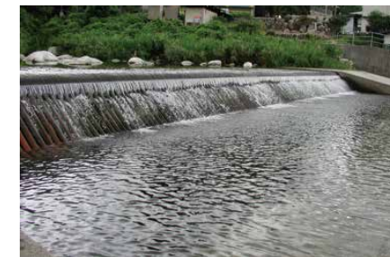
バースクリーン複合型溪流取水工
