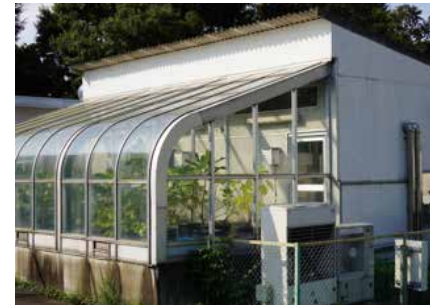
生物環境調節実験施設(バイオトロン)
