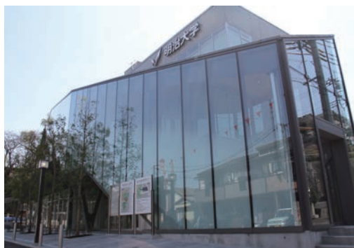
センター外観 Appearance of the Center
