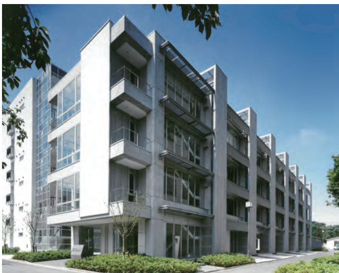
ハイテク・リサーチ・センター 理工学部と農学部が合同で利用する施設で、 様々な研究設備・装置が設置されています。
