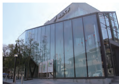
センター外観 Appearance of the Center
