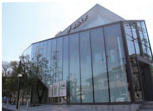
センター外観 Appearance of the Center
